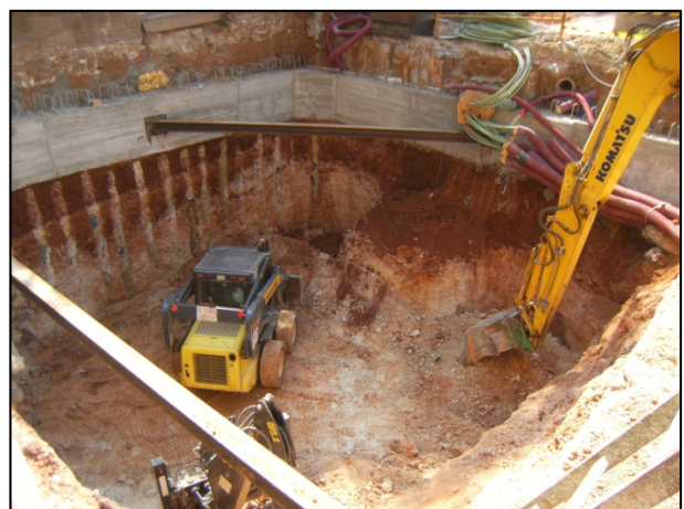
FOTO 20. Vista general del rebaix efectuat al costat nord-oest del Pavelló de l'Administració.
