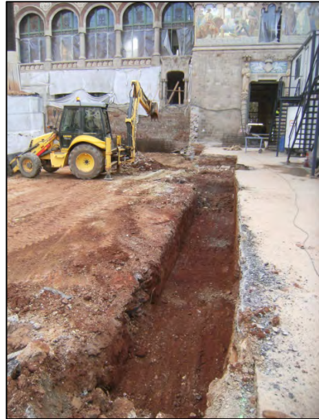
FOTO 18. Vista d'una de les rases per a la construcció de les pantalles de formigó..
