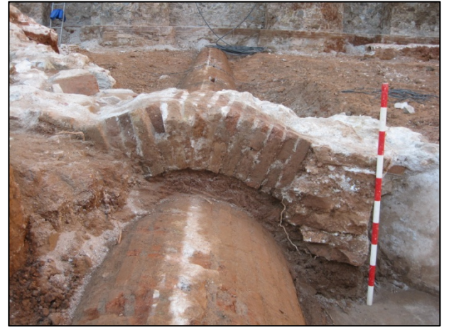
FOTO 10. Detall de l'estructura de reforç (UE 13).
