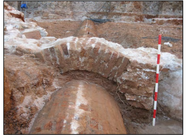
FOTO 10. Detall de l'estructura de reforç (UE 13).
