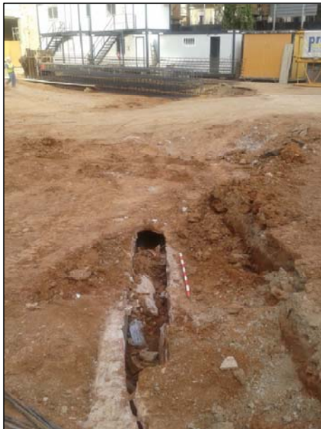
FOTO 11. Vista del tram de claveguera UE 14.
