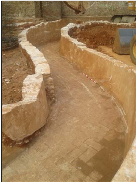
FOTO 5. Vista de detall d'un tram del canal UE 08.
