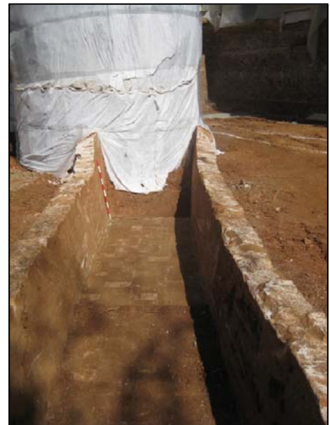
FOTO 4. Vista de detall d'un tram del canal UE 08.
