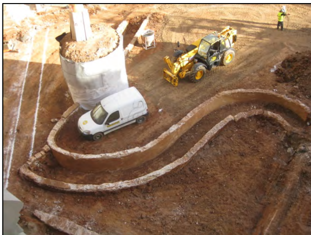
FOTO 3. Vista general del canal UE 08
