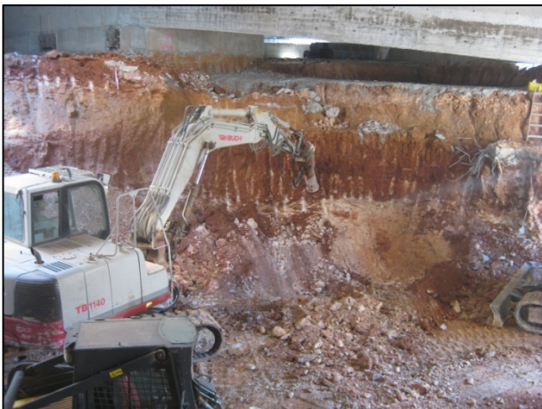
FOTO 23. Procés de rebaix "en mina"
