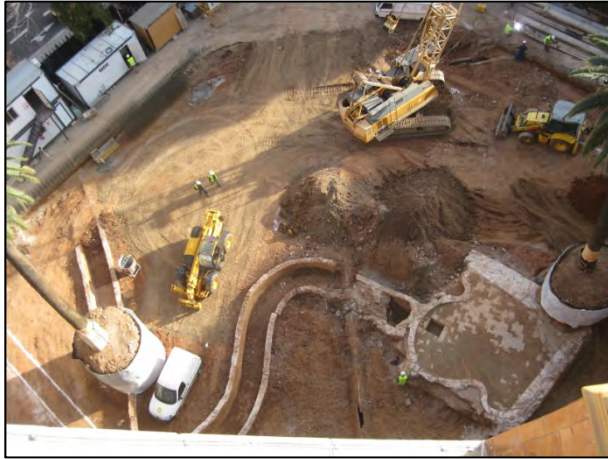
FOTO 1. Vista general de la font (UE 04) i del canal (UE 08).
