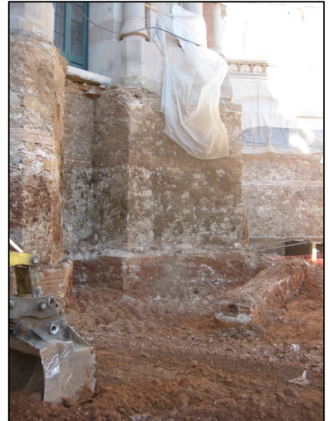
FOTO 14. Detall de la canalització de ceràmica reforçada (UE 19).
