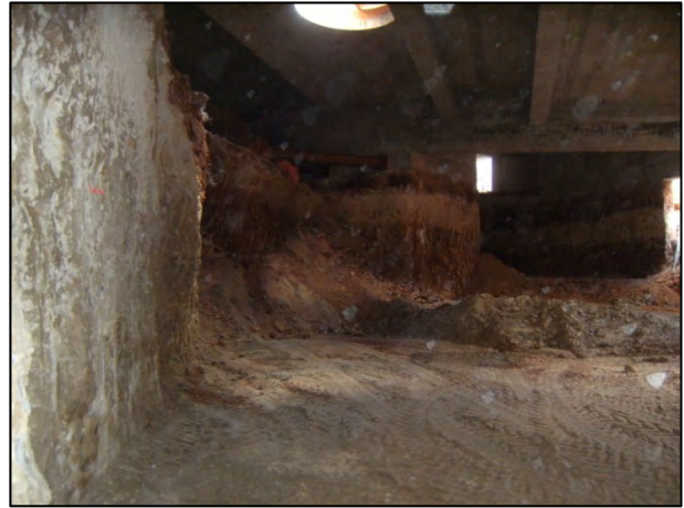
FOTO 22. Vista del rebaix "en mina" corresponent a la segona fase de l'obra.
