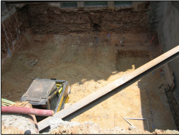
FOTO 21. Vista general del rebaix efectuat al costat nord-oest del Pavelló de l'Administració.
