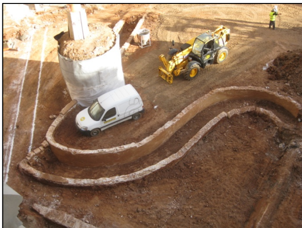
FOTO 3. Vista general del canal UE 08
