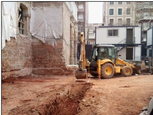
FOTO 19. Vista d'una de les rases per a la construcció de les pantalles de formigó..
