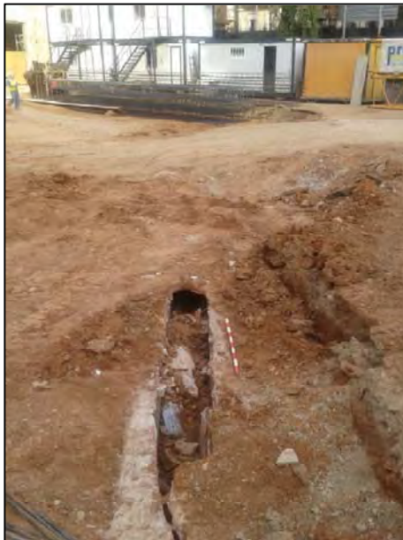
FOTO 11. Vista del tram de claveguera UE 14.
